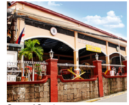
Covered Court Barangay Hagdan Bato Itaas
